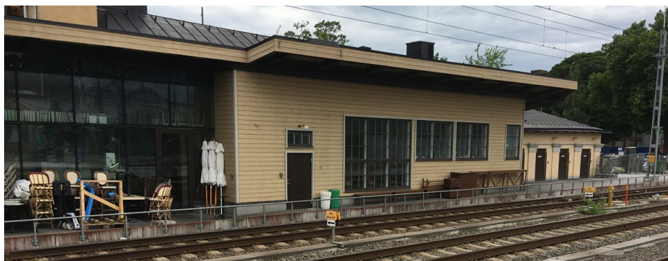
Figur 14. Uppsala centralstation, träfasad (vy mot nordväst).
