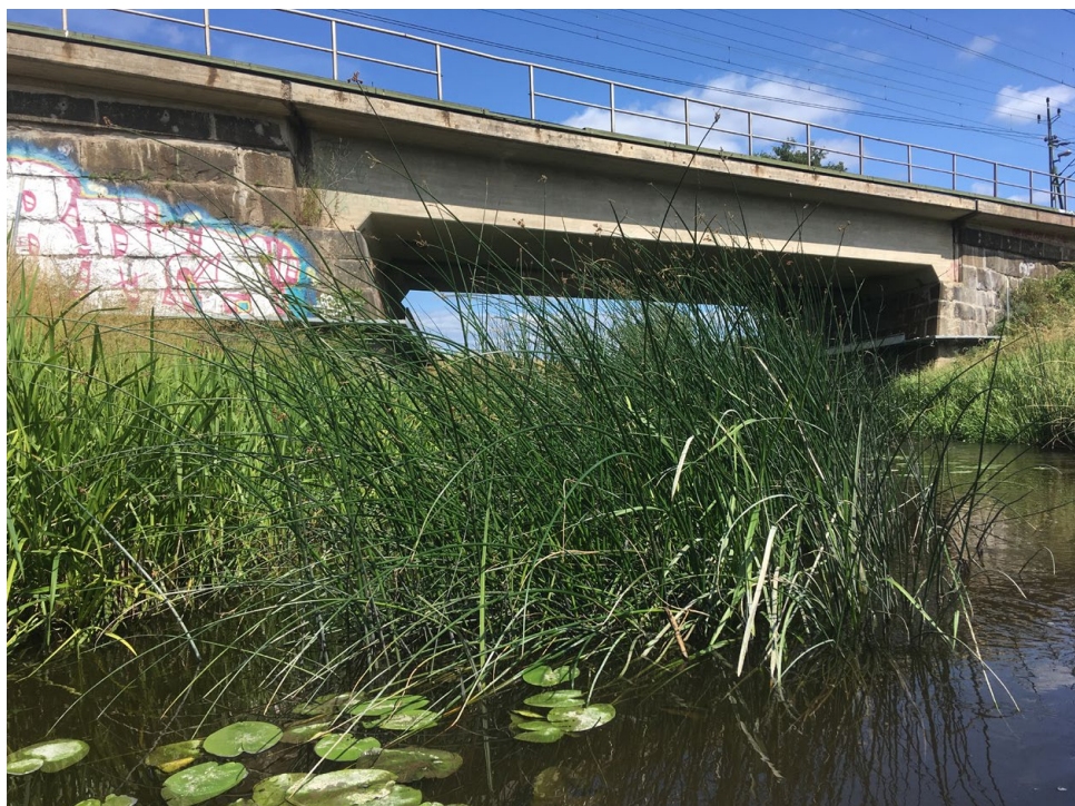
Figur 30. Befintlig bro över Sävjaån.
