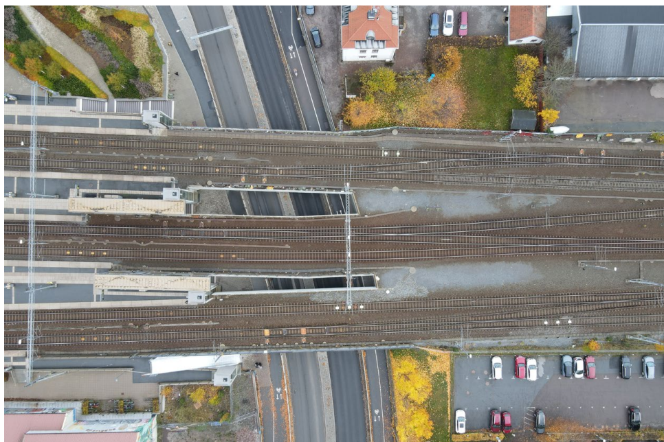
Figur 10. Befintliga broar över Strandbodgatan.
