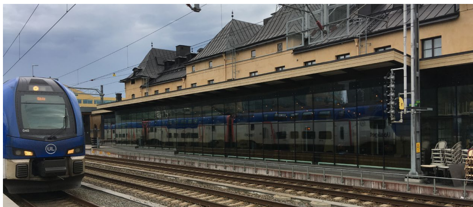
Figur 15. Uppsala centralstation, glasveranda (vy mot sydväst).
