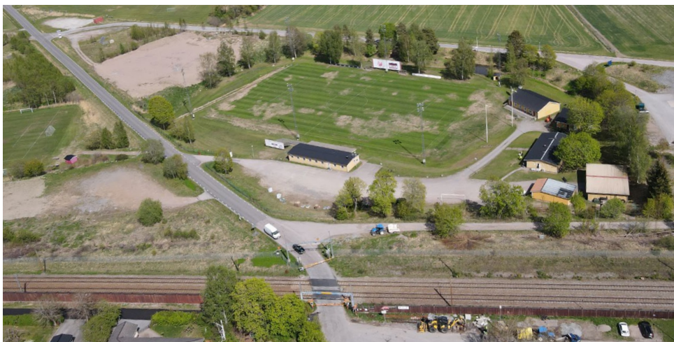
Figur 12. Befintlig planpassage vid Gårdsvägen.
