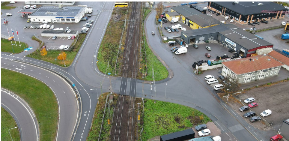
Figur 11. Befintlig planpassage vid Vimpelgatan.
