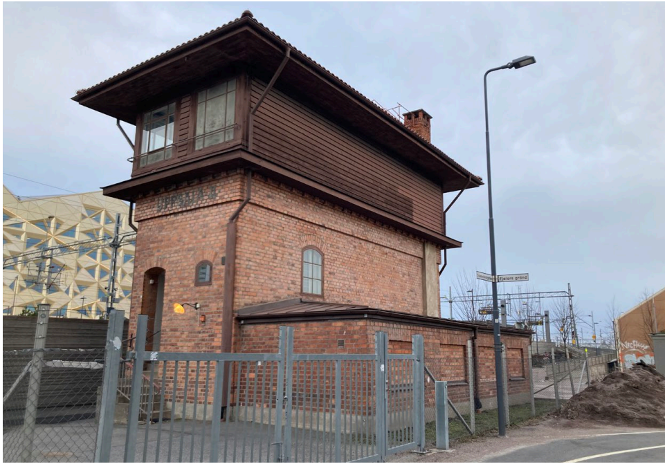
Figur 52. Ställverket med befintlig tillbyggnad från 1930-talet.
