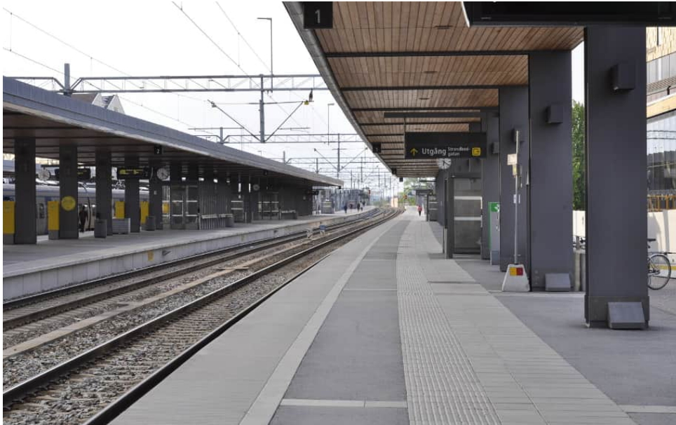
Figur 7 visar spår 1 på Uppsala Centralstation.
