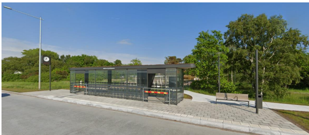
Figur 8. Befintlig nybyggd busshållplats vid Nyckelhålsparken invid väg 100.
