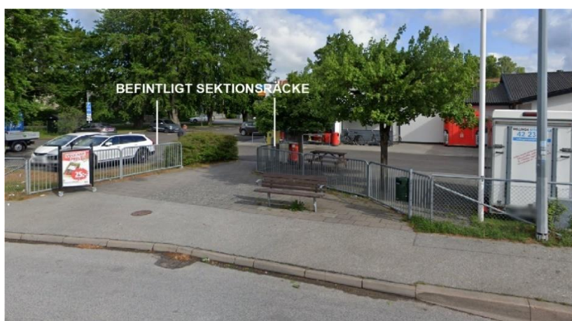
Figur 16. Bild visar befintlig busshållplats med befintliga sektionsräcken. Dessa räcken lackeras i kulör RAL 7022 enligt Skånetrafikens riktlinjer. De målas på plats eller ersätts med ett nytt räcke i denna kulör. Befintlig bänk ersätts med ny enligt Skånetrafikens riktlinjer samt kompletteras med en papperskorg och digital tavla enligt Skånetrafikens riktlinjer.
