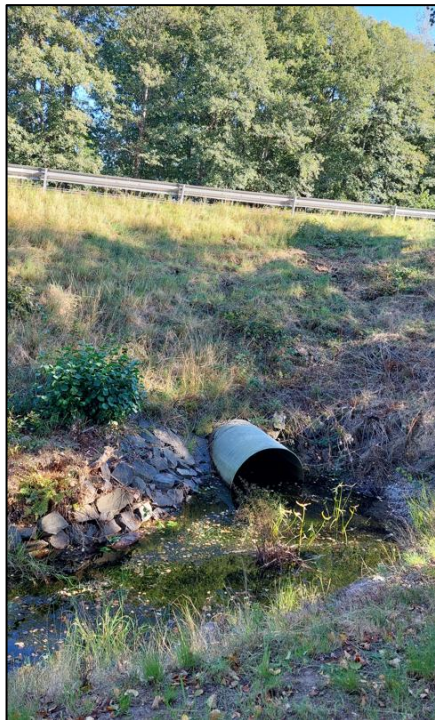
Figur 25. Befintlig trumma under E22 vid Tinderedsbäcken.
