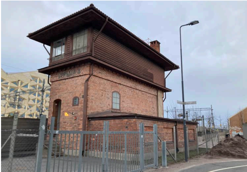
Figur 52. Ställverket med befintlig tillbyggnad från 1930-talet.
