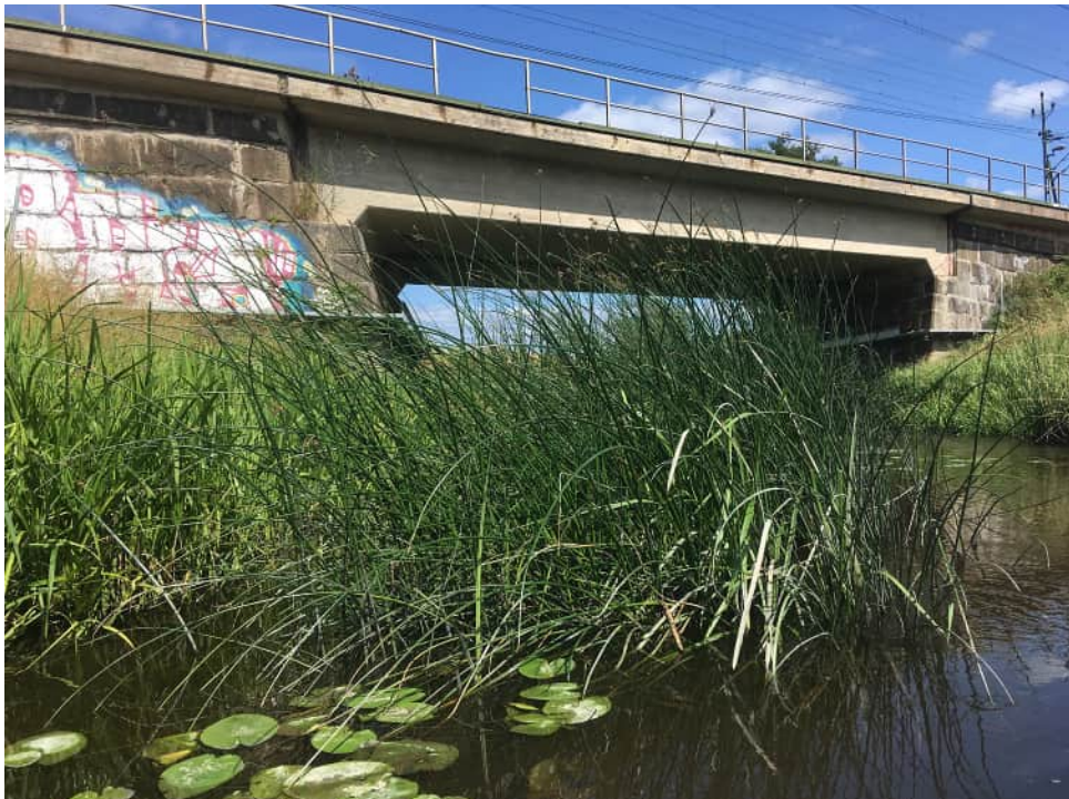
Figur 30. Befintlig bro över Sävjaån.
