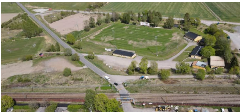
Figur 12. Befintlig planpassage vid Gårdsvägen.
