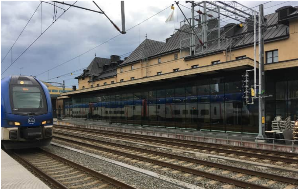
Figur 15. Uppsala centralstation, glasveranda (vy mot sydväst).
