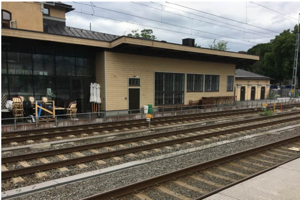
Figur 14. Uppsala centralstation, träfasad (vy mot nordväst).
