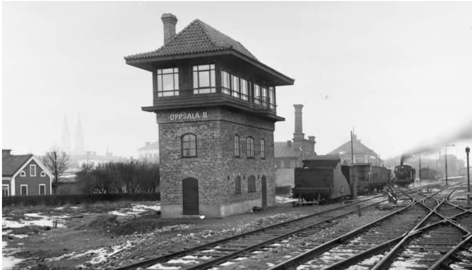
Figur 26. Ställverket vid Uppsala station. Foto: Berger Ekelid Järnvägsmuseet.
