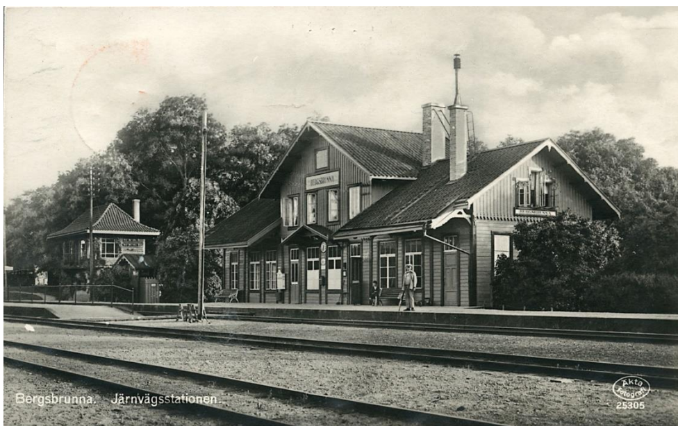
Figur 22. Bergsbrunna nu rivna stationshus med tillhörande ställverk.
