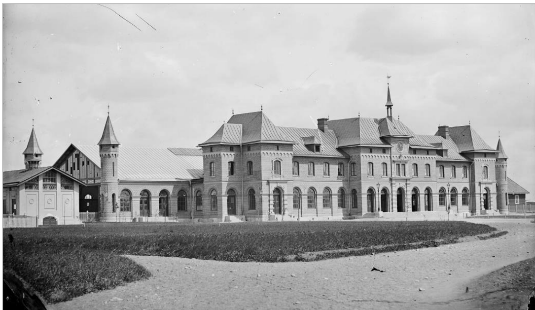
Figur 16. Uppsala centralstation troligen i slutet av 1860-talet. Här syns spårhallen sticka fram med sin glasprydda gavel till vänster i bild. Längst till höger syns hörnet på det första godsmagasinet. Den byggnad som står längst till vänster i bild hade en idag okänd funktion och revs senast på 1910-talet då stationshuset förlängdes en andra gång. Foto: Henri Osti, ur Upplandsmuseets bildarkiv.
