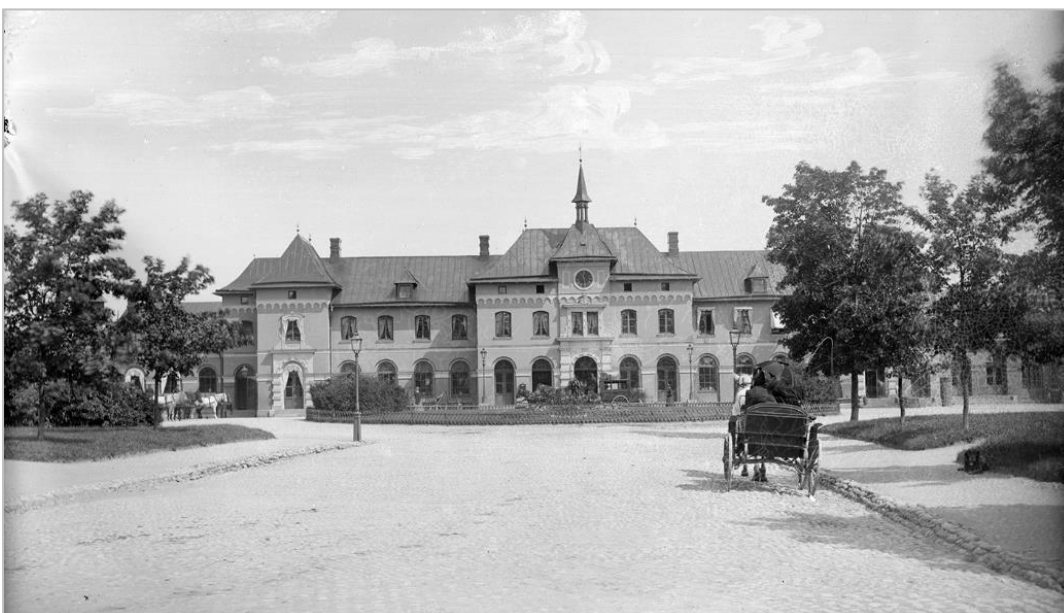
Figur 18. Uppsala station efter tillbyggnaden vid slutet av 1880-talet. Flyglar i en våning är tillagda på de båda gavlarna och hela huset är putsat. Foto: Henri Osti, ur Upplandsmuseets bildarkiv.
