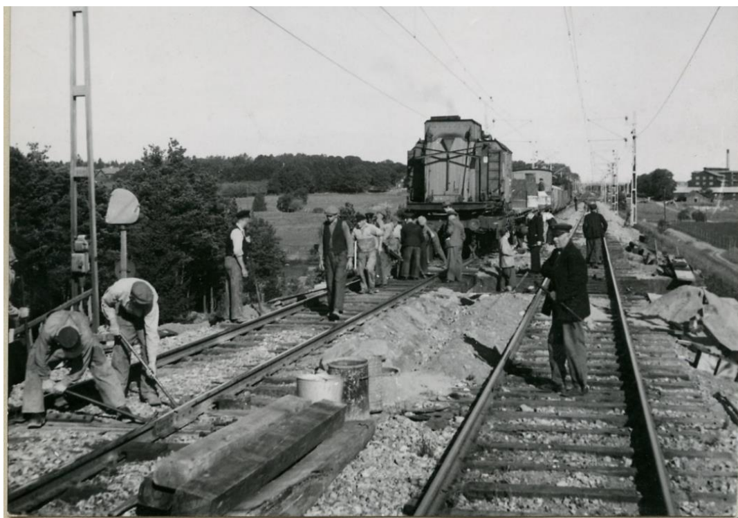
Figur 25. Arbete med vägporten vid Vallby – Asphagen år 1945. Foto Järnvägsmuseet
