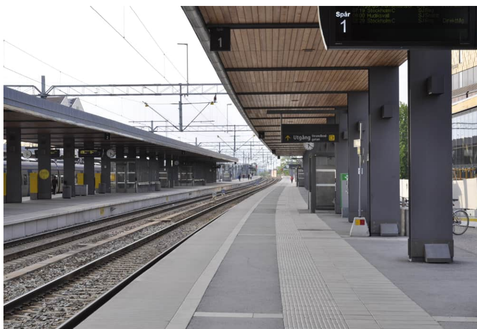
Figur 6 visar spår 1 på Uppsala Centralstation.
