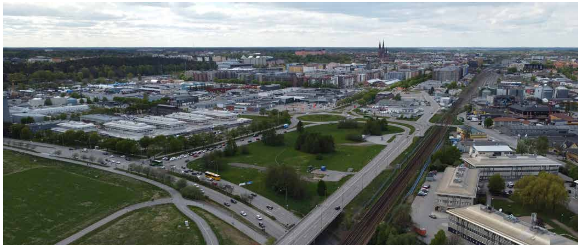
Figur 12. Drönarbild på järnvägssträckan från Kungsängsleden med utblick nordväst mot centrala Uppsala.
