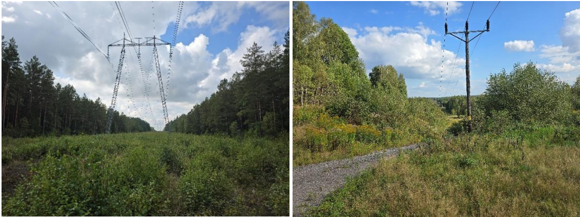
Figur 14. Vänstra fotot visar SVK:s luftledning medan E.on och VEAB:s ledningar är av typen som visas i högra fotot.
