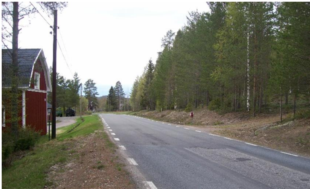
Figur 7.2.9. Vy norrut, öster om bron över Alån. Den nya vägsträckningen kommer att gå genom skogen med lokalen med husgrunden till höger i bild.
