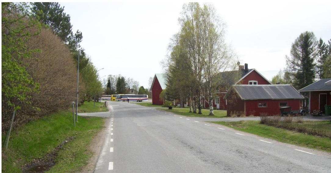
Figur 3.2.1. Väg 582 genom Alvik saknar helt gång- och cykelvägar, har smala vägrenar och bebyggelsen ligger nära vägen.
