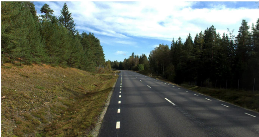
Figur 3. Väg 25, en nio meter bred tvåfältsväg med flacka diken.
