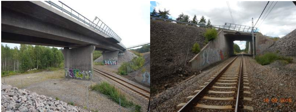
Bild 11. Läge I, underpassage. Åtgärder vid befintlig bro över järnväg (knr 4-548-1); breddning av tunnel eller nybyggnation av tunnel i anslutning till befintlig. Medelgoda förutsättningar för viltrörelser. Foton från BaTMan.
