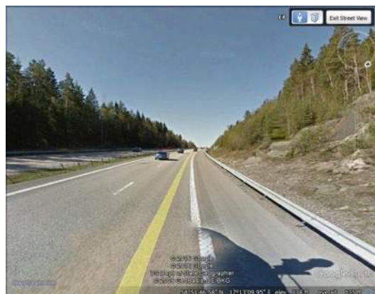
Bild 22. Läge R, överpassage. Vissa topografiska förutsättningar för överpassage (sydvästra sidan av vägen). Goda förutsättningar för viltrörelser. Bild från Google streetview.
