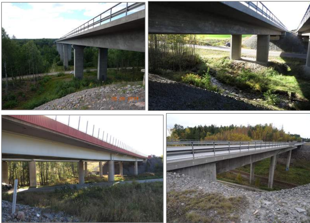
Bild 2. Existerande längre E4-broar med förmodat god funktion för vilt: bro över Göta kanal vid Norsholm, bro över allmän väg 1 km nv Korsbäcken, bro över Kilaån och väg vid Ålberga gård, bro över järnväg n om Spårtoorp. Foton från BatMan.
