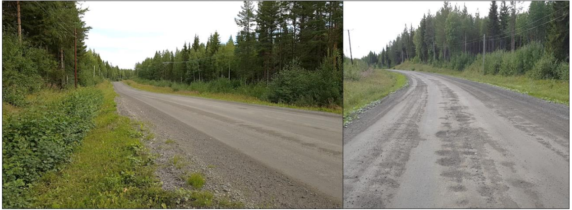
Figur 4. Väg 829 strax norr om Lövberga. Vägen är på långa sträckor omgiven av skog. Diken är grunda och oeftergivliga stolpar står nära vägen.
