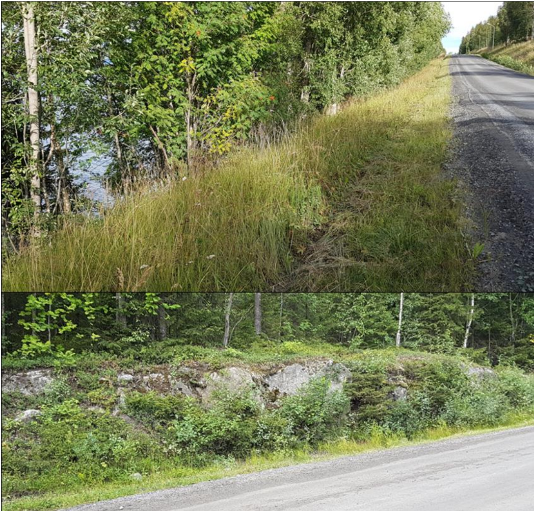
Figur 8. Exempel på partier längs väg 829 som i vägförslaget föreslår förbättringar utifrån trafiksäkerhet. Vid branta lutningar mot vatten föreslås räcke (övre bilden) och säkerhetszonen rensas från oeftergivliga föremål, i detta fall en berghäll (undre bilden).
