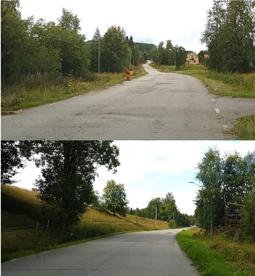
Figur 3. Övre bilden: exempel från parti av vägen med omfattande skador och ojämnheter i beläggningen. Nedre bilden: miljö i Lövberga.
