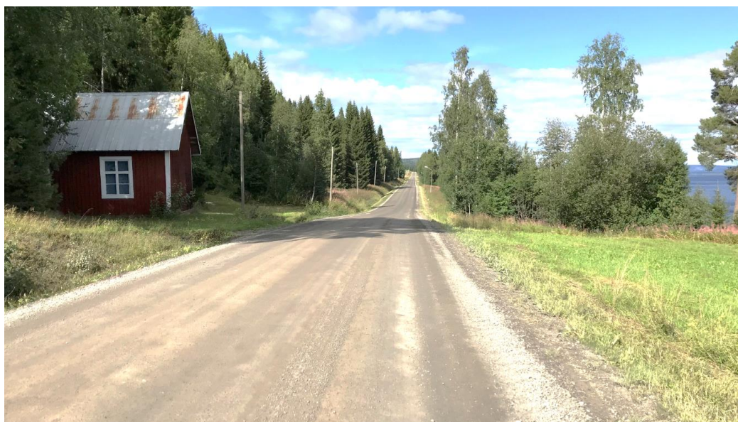
Figur 13. Långa sträckor av väg 829 utgörs av raksträckor med backkrön. Foto från norr om Havsnäs.
