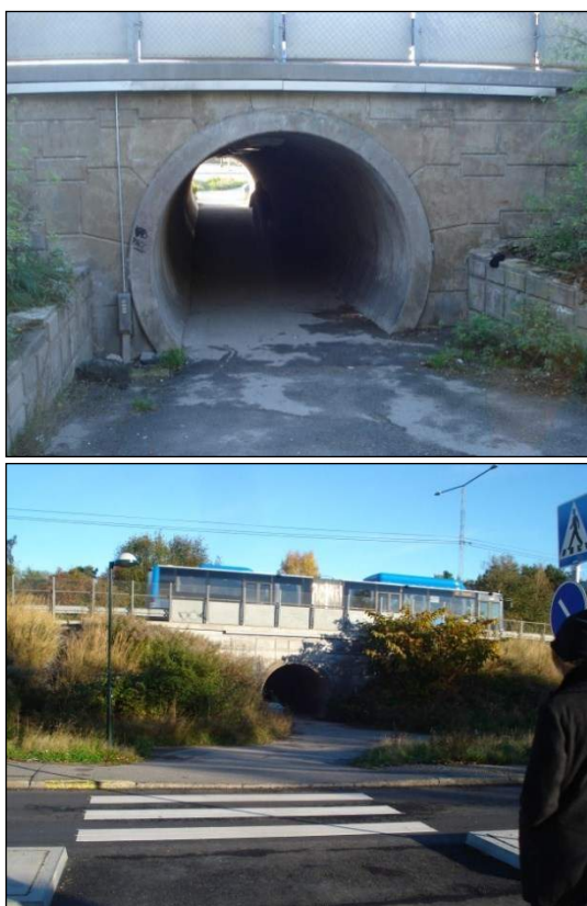
Figur 10 Gångtunneln mellan hållplatserna.
