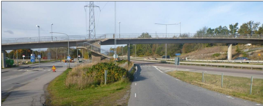
Figur 11 Gång- och cykelbro strax väster om bytespunkten
