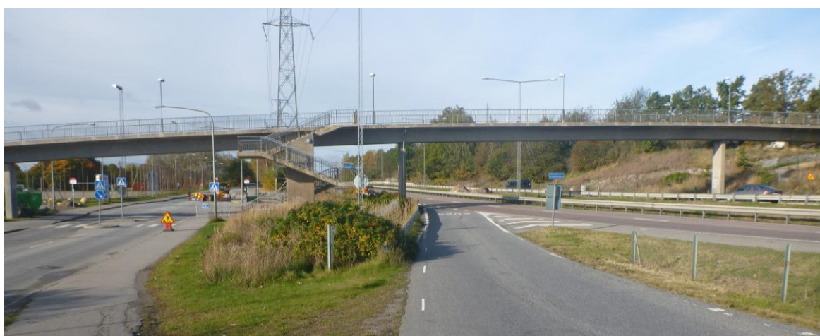
Figur 7. Gång- och cykelbro strax väster om bytespunkten.
