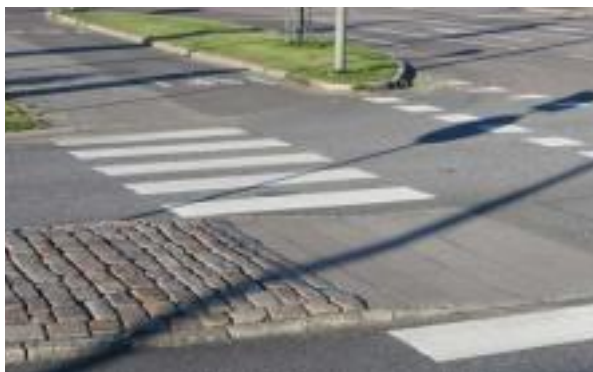
Refugytorna vid byte bil-buss beläggs med storgatsten/marksten. Foto, COWI
