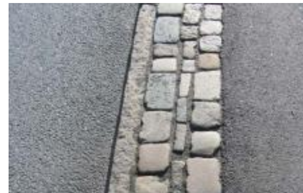
Storgatsten markerar GC-vägens kant och tydliggör avgränsningen mellan fordon och oskyddad trafikant. Foto, COWI
