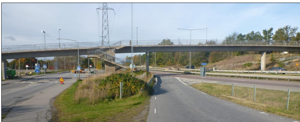
Figur 8. Gång- och cykelbro strax väster om bytespunkten.
