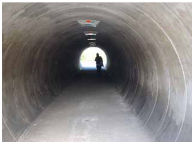
Figur 8: Tunnel under Tyresövägen.
