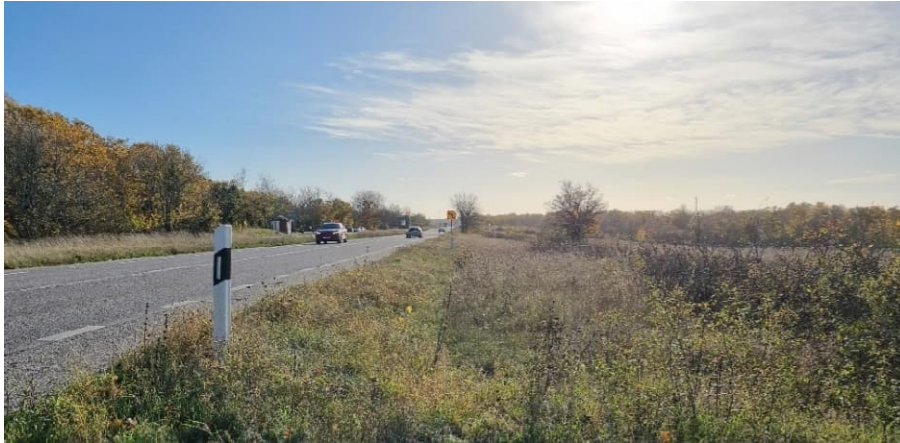
Figur 23. Bild tagen mot sydost med naturreservatet Västra Sörby till vänster samt öppen jordbruksmark och längre bort Halltorp naturreservat till höger.
