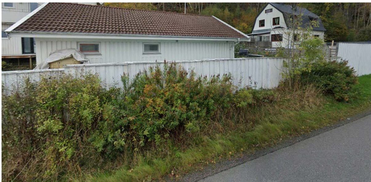
Figur 4.7.2:3. Befintlig bullerskyddsskärm på fastigheterna Kungsbacka Alafors 3:15 och Kungsbacka Alafors 3:16 (bild mot väster, Google maps).
