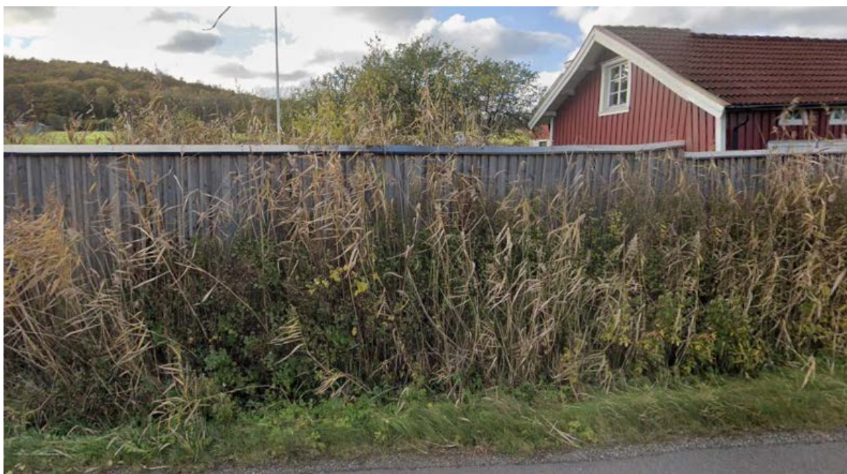
Figur 4.7.2:4. Befintlig bullerskyddsskärm vid fastighet Mölndal Skäggered 1:41 (bild mot väster, Google maps).
