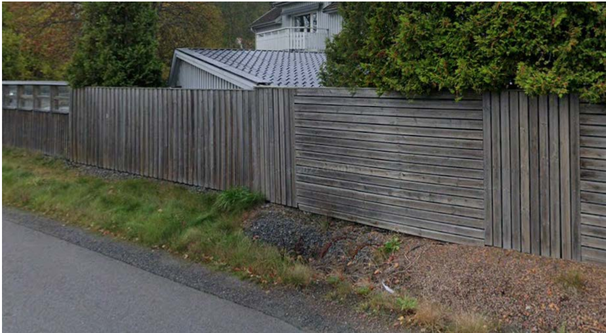
Figur 4.7.2:2. Befintlig bullerskyddsskärm på fastigheterna Kungsbacka Alafors 2:41 och Kungsbacka Alafors 2:29 (bild mot väster, Google maps).
