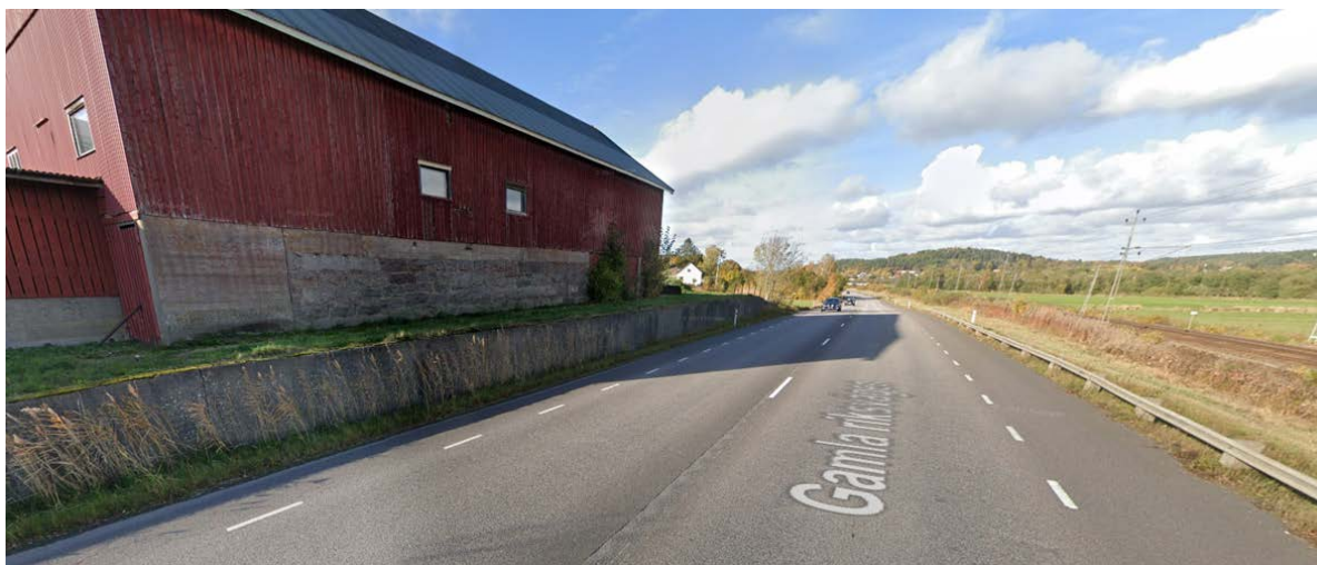
Figur 5.1.1.5:1 Befintlig stödmur utmed väg 970/513 vid ladugård, sektion ca 3/400–3/500.
