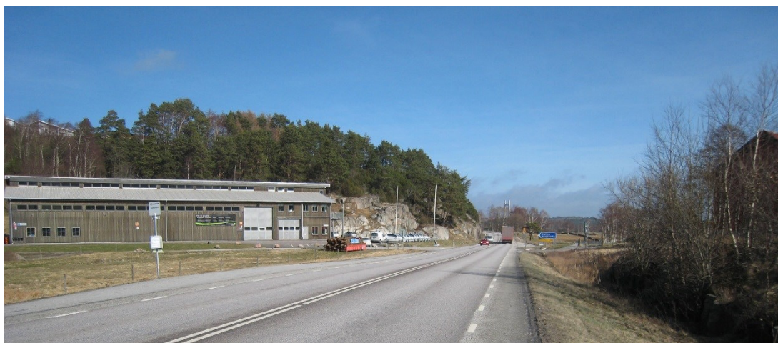
Figur 9 Väg 169 riktning mot Myggenäs.
