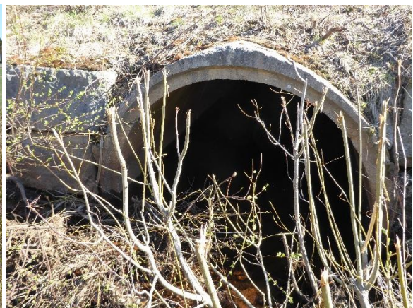
Figur 3.7–4 Vattendrag som avleds från sjön Noret. Till vänster ses vattendraget uppströms allmän väg 667 och till höger ses befintlig vägtrummas inlopp innan genomledning under allmän väg 667.
