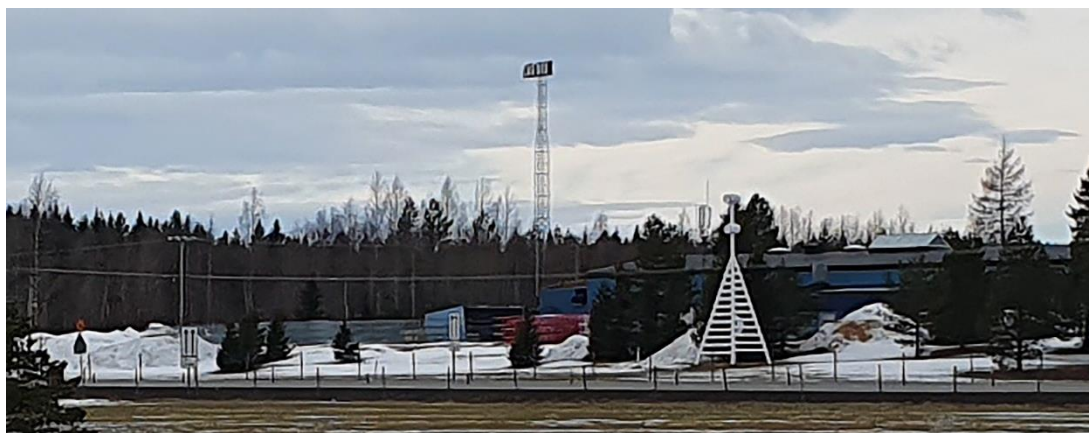
Figur 9. Vy över Spiran och fackverksmasten med E4 i förgrunden.
