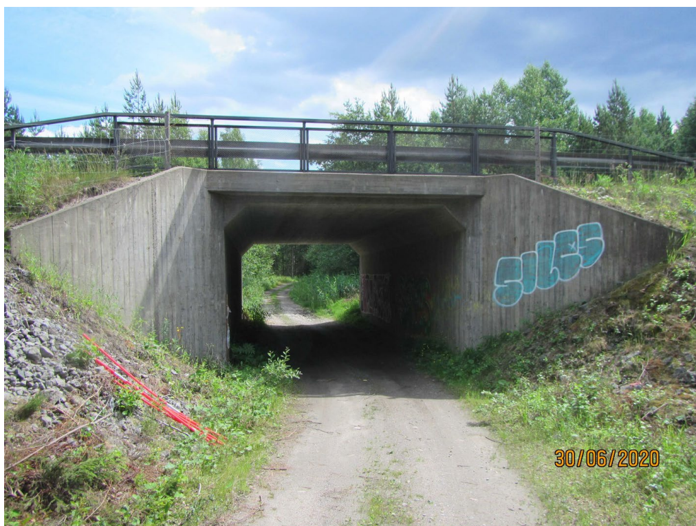
Figur 12. Befintlig vägbro över Bostigen, foto Trafikverket (Batman)
