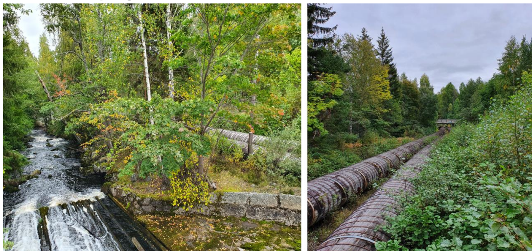
Figur 16. De trätuber som ligger längs med forsen vid Spångholmsdammen som anses känsliga för påverkan av ny järnväg.
