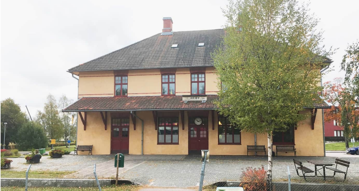
Figur 11. Stationshuset med entréplats mot spåren, belagd med smågatsten.
