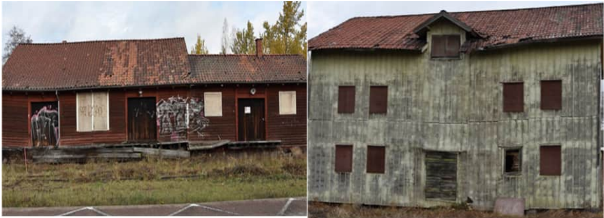
Figur 13. Vänster bild: Det röda godsmagasinet/södra fasad med raserad lastbrygga av trä synlig. Höger bild: Det gröna kolhuset/godsmagasinet/södra fasad.
