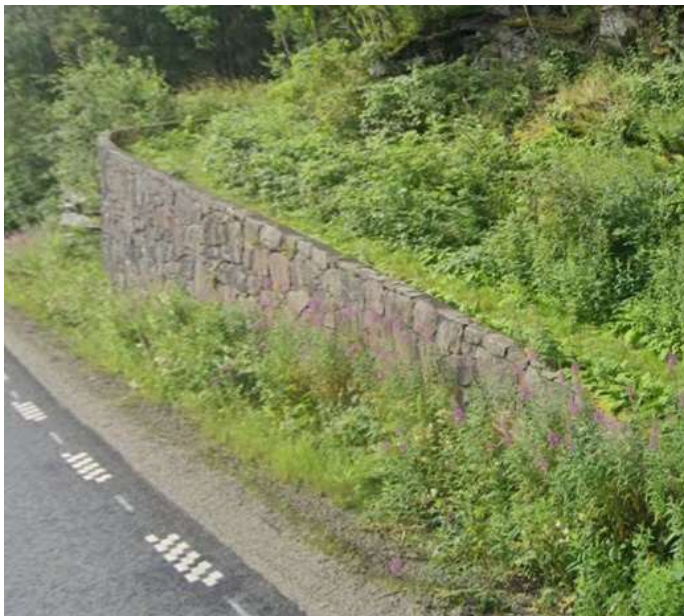
Figur 15 Stödmur sedd norrifrån (källa: ©2024 Google Street View).
