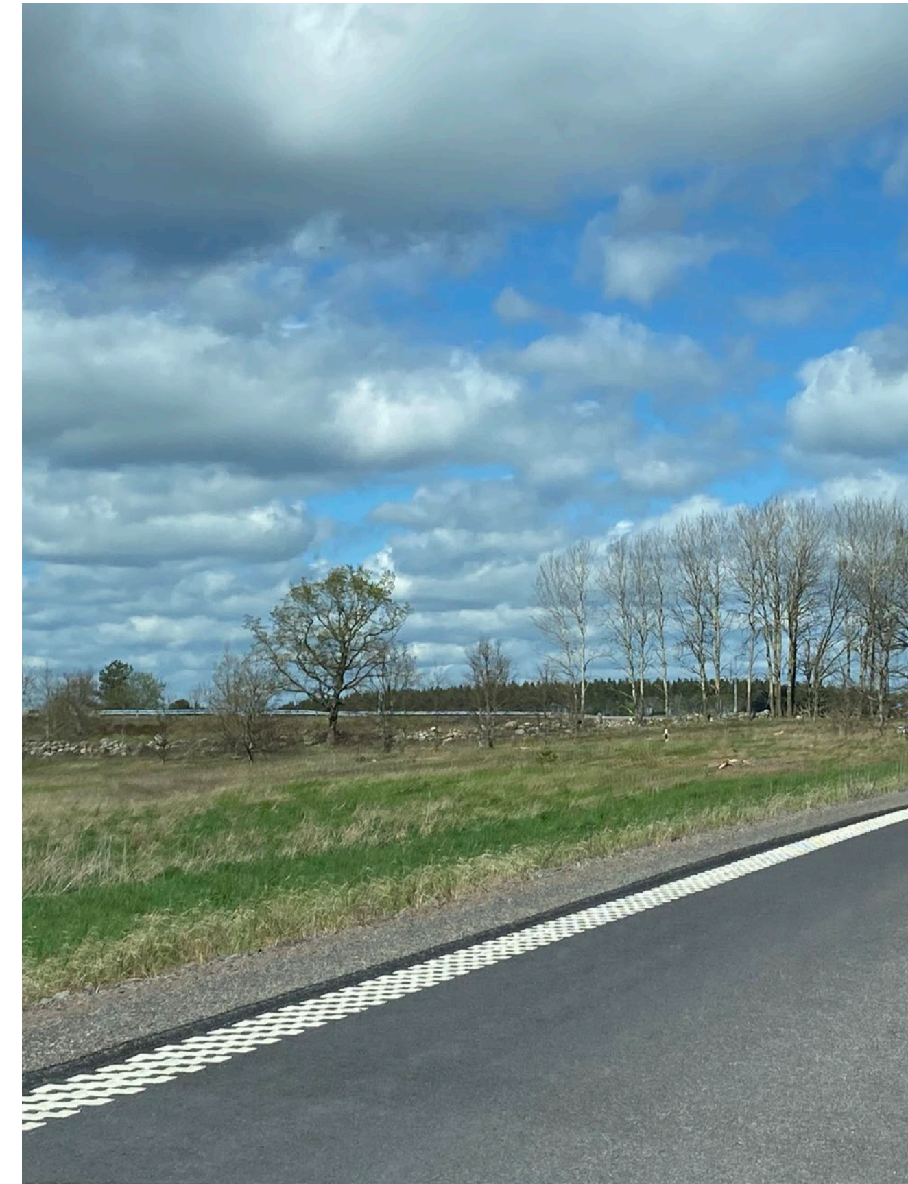
Figur 2: Vy från norrgående avfartsramp upp mot trafikplats Söderåkra
