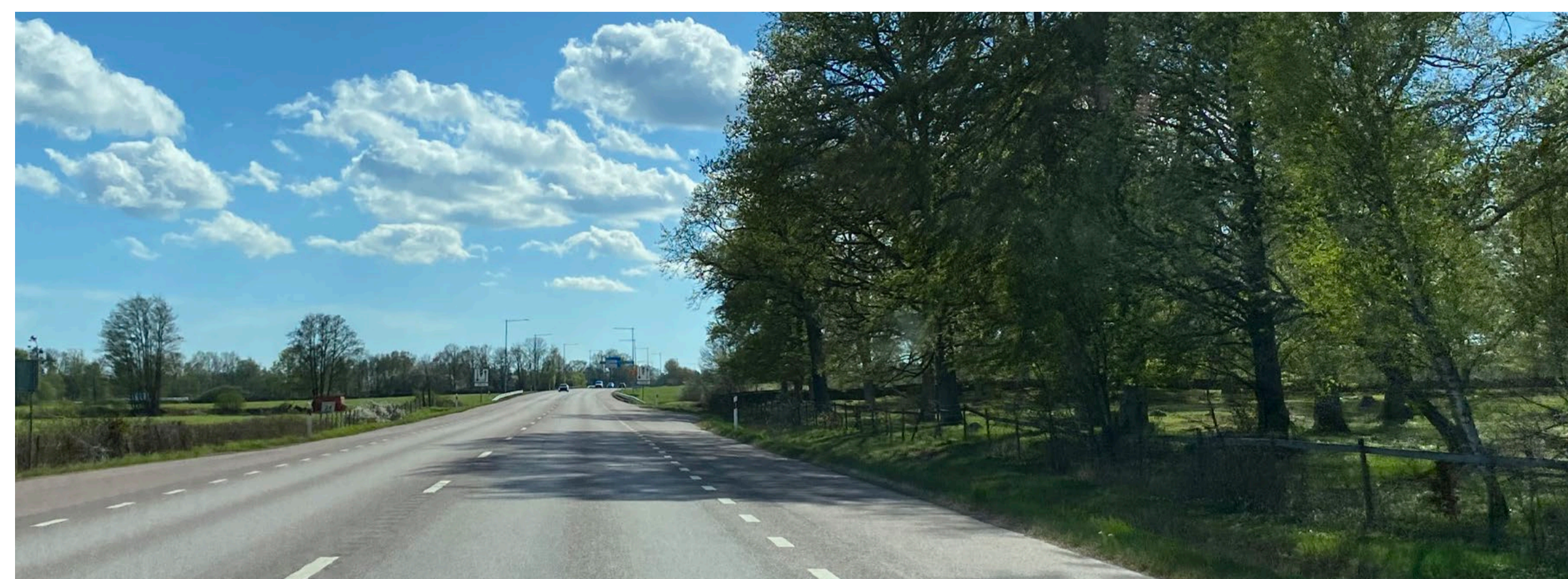
Figur 1: Vy söderut på befintlig E22 (sträcka med tillräcklig bredd)
