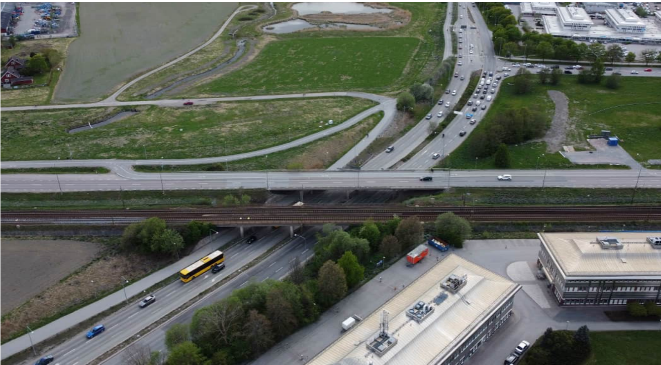
Figur 19. Befintlig planskild korsning, järnväg-Kungsängsleden.
