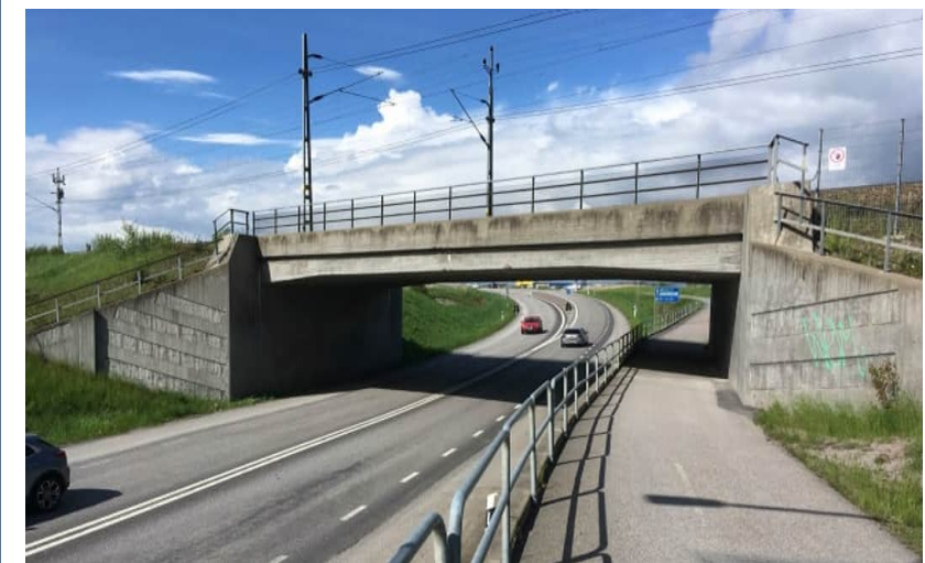
Figur 37. Bro över väg 255, vid Kuggebro.
