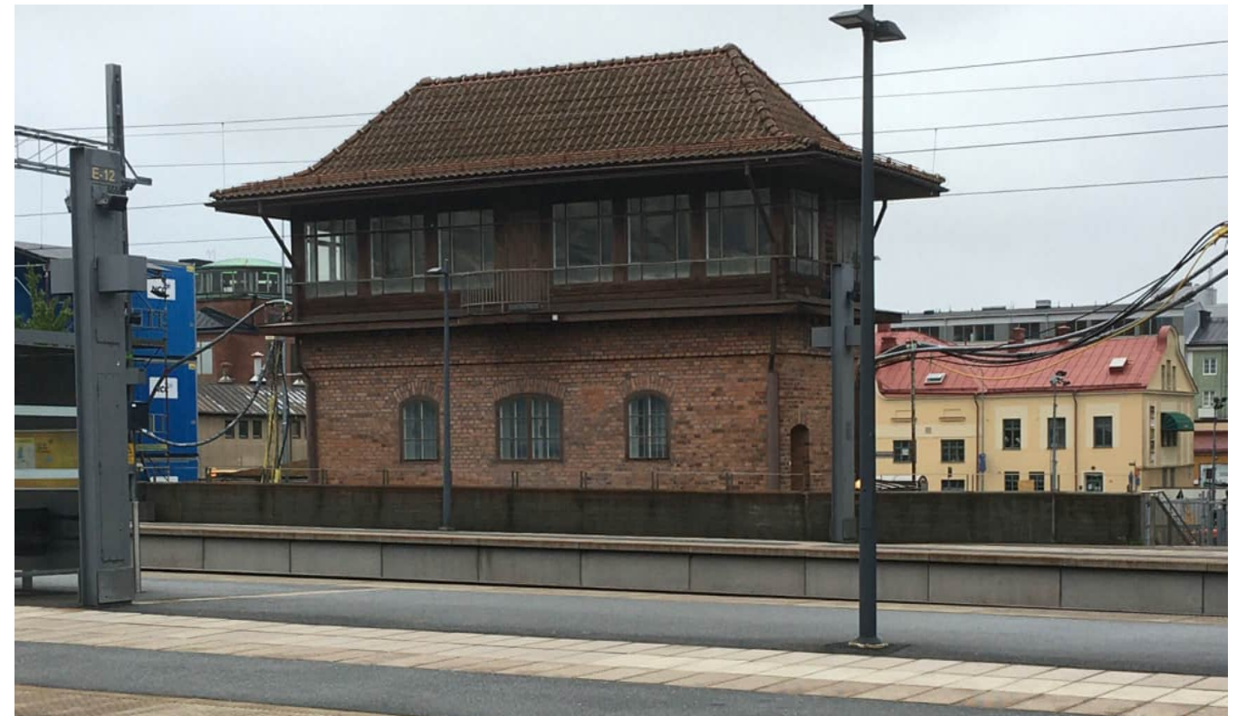
Figur 14. Ställverksbyggnaden från 1910-talet.
