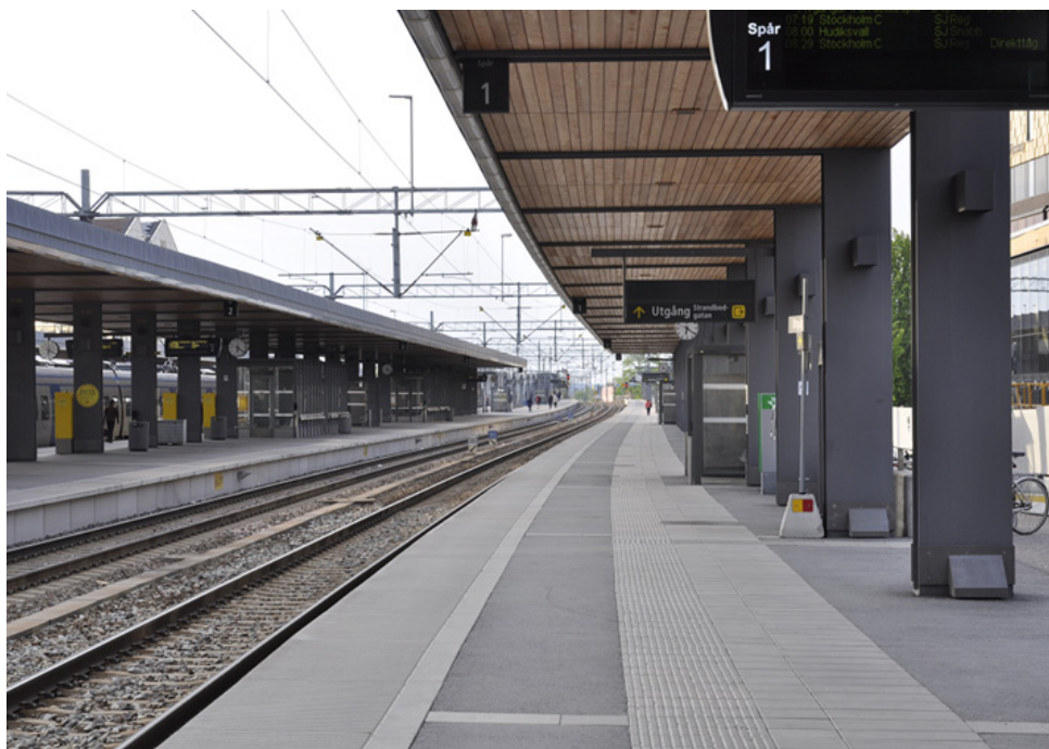
Figur 7 visar spår 1 på Uppsala Centralstation.
