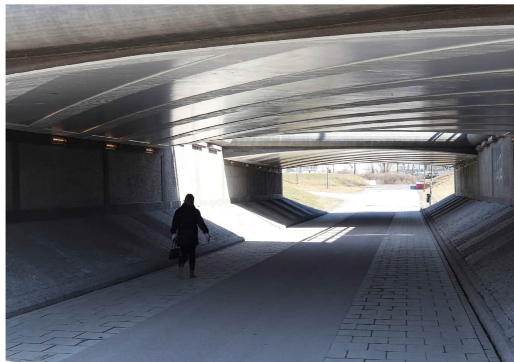
Figur 7. Gång- och cykelport med ljusinsläpp och separerat utrymme för gående och cyklister (Boverket, 2022).
