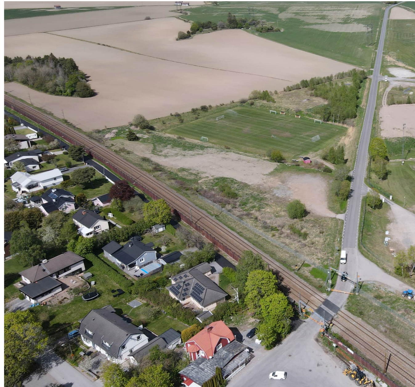
Figur 20. Bild på Gårdsvägens plankorsningspassage i Bergsbrunna.
