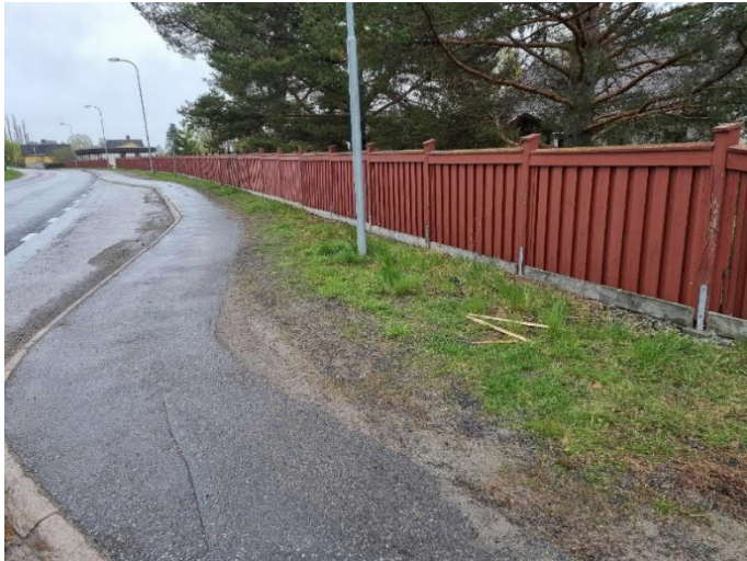
Figur 17. Befintligt bullerplank som finns beläget utmed den södra sidan av Centrumvägen mellan Vårdhemsvägen och Sörviksgatan.
