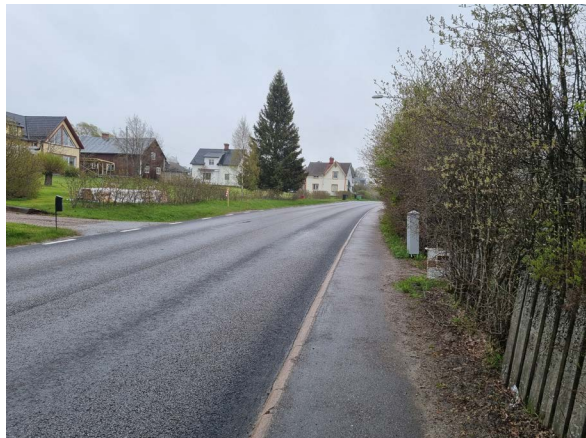
Figur 31. Smal gångbana längs ena sidan av vägrummet.
