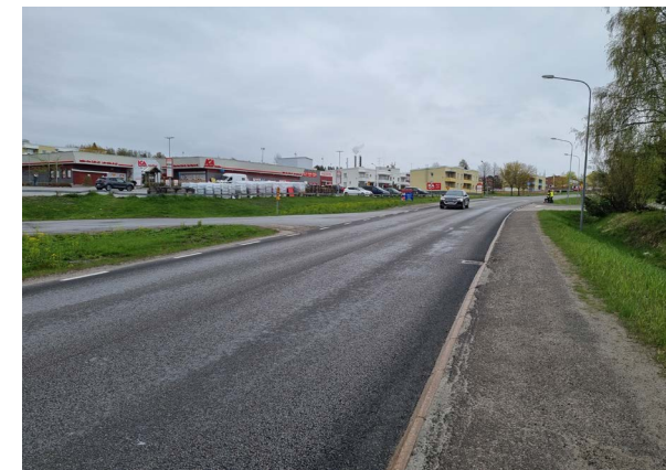
Figur 25. Vägrummet i anslutning till centrum upplevs som öppet, odefinierat och otydligt.
