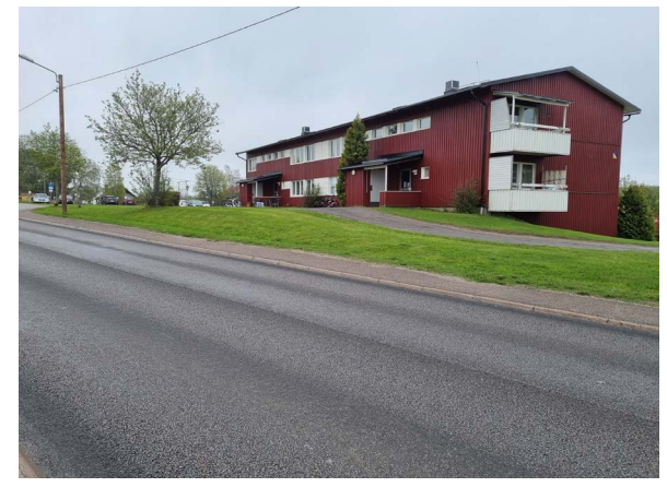
Figur 30. Suterränghus på den södra sidan av Centrumvägen.
