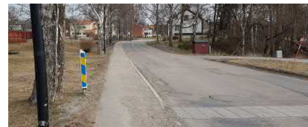
Bild 11. Befintlig upphöjd behålls, th i bild. Trädallé tv i bild tas ned och ersätts med en ny trädrad i skiljeremsa.
