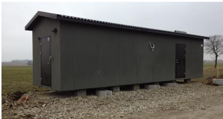
Figur 9 Exempel på utformning av teknikhus.
