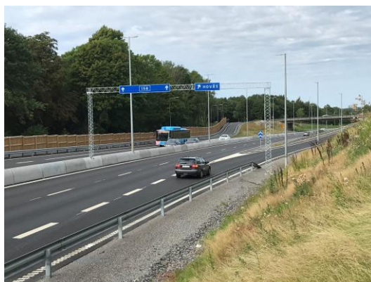
Väg 158 Kollektivtrafikkörfält Hovåsmotet - Brottkärrsmotet. Foto: Trafikverket
