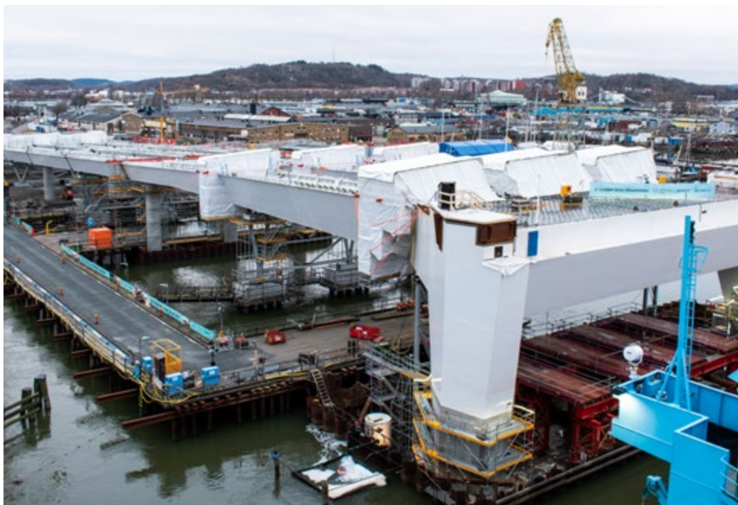
Byggnation av Hisingsbron. Foto: Katrin Svensson
