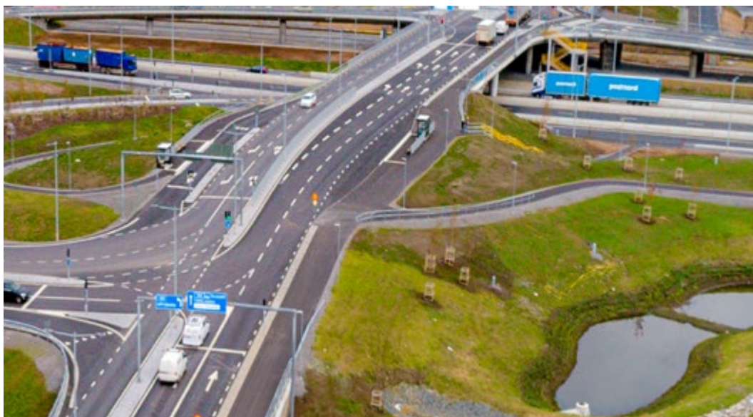
Sörredsmotet: Sörredsmotet efter färdigställande. Foto: Trafikverket
