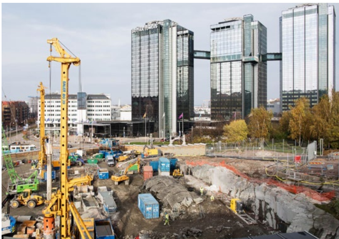
Byggarbetsplats Västlänken deletapp Korsvägen. Foto: Trafikverket
