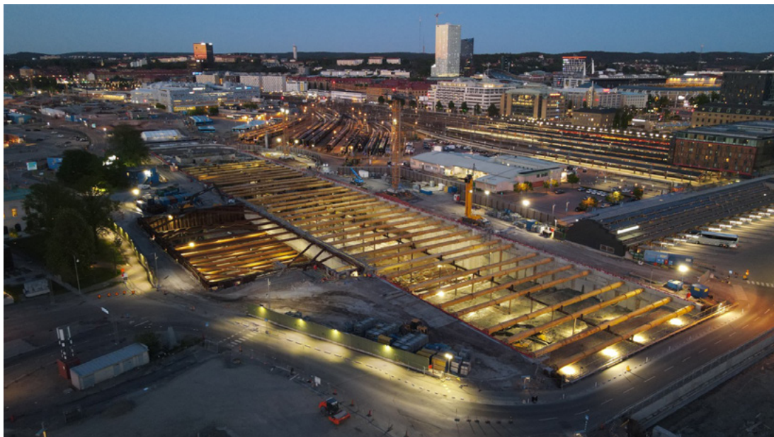
Tågtunnel Etapp Centralen. Foto: Trafikverket
