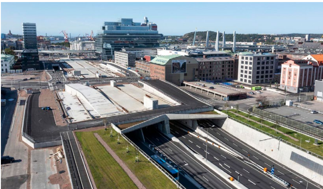
Gullbergstunneln, nedsänkning av E45. Ovanpå tunnelns tak planerar Göteborgs stad för bebyggelse. Foto: Kasper Dudzik
