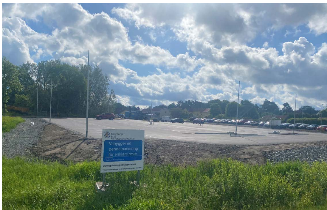
Foto Olofstorps pendelparkering som färdigställdes under 2024. Fotograf Jörgen Tranemyr
