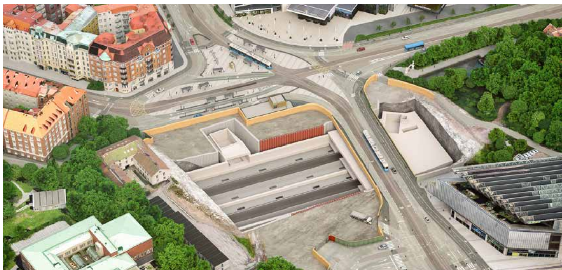
Vy över Korsvägen med schakt för den underjordiska stationen. Foto: NCC
