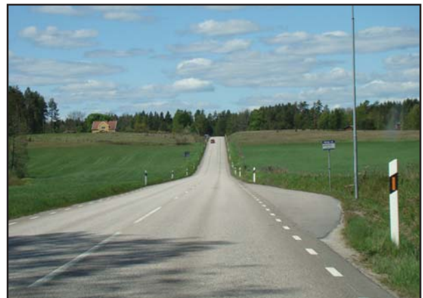
Krön som profiljusteras före betongindustri vid Fiskareby.
