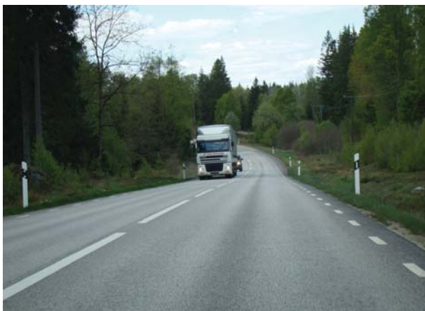
Tung trafik går längs med väg 27. Risken för att en olycka med farligt gods är relativt stor.
