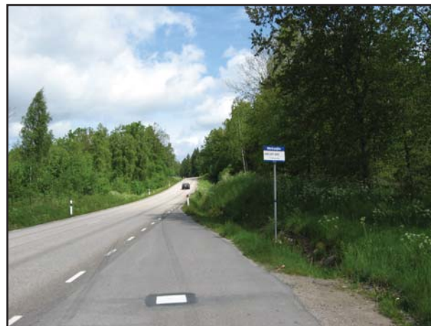
Busshållplatserna längs väg 27 är normalt utformade med bussficka, men saknar oftast väderskydd och gångväg till hållplatsen.
