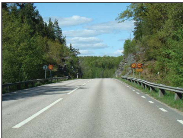
Vägens profil har låg standard med dålig sikt vid många backkrön. Här kombinerat med bergskärningar på båda sidor.
