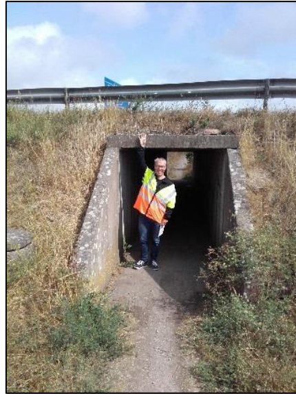
Figur 6. Befintlig gångtunnel vid Algutsrum.
