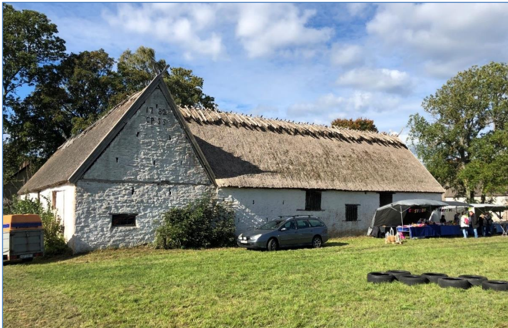
Figur 12. Ekonomibyggnaderna från 1700-talet till Glömminge prästgård. Väggarna är uppförda av kalksten och byggnaderna har vasstak.
