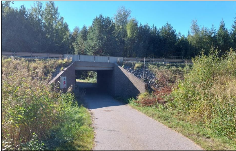
Figur 19. Befintlig utformning av bro 8-868-1.
