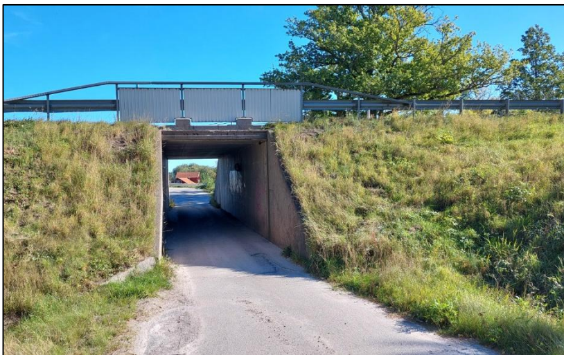
Figur 20. Befintlig utformning av bro 8-809-1.
