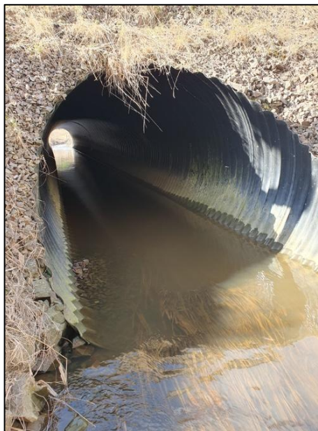
Figur 17. Befintlig trumma under E22 vid Baggetorp.
