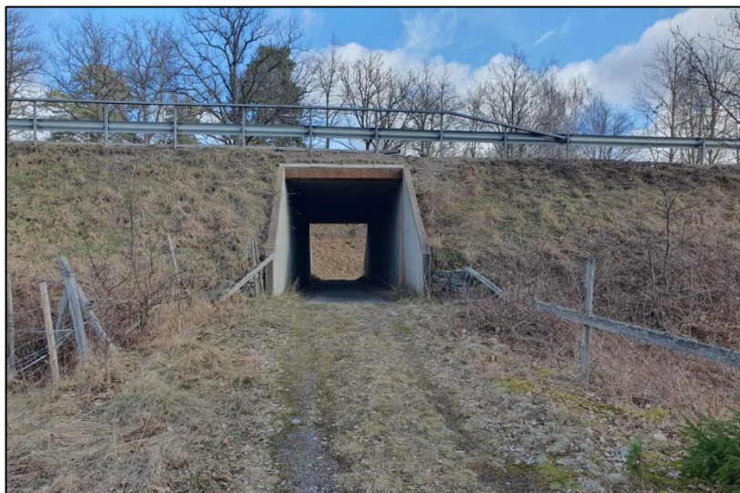
Figur 21. Befintlig utformning av bro 8-849-1.
