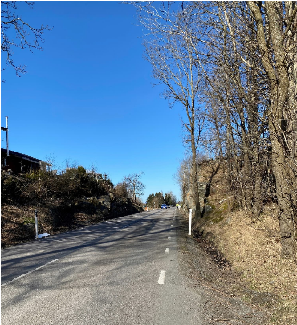
Figur 16. Foto på bergskärningen längs väg 563.
