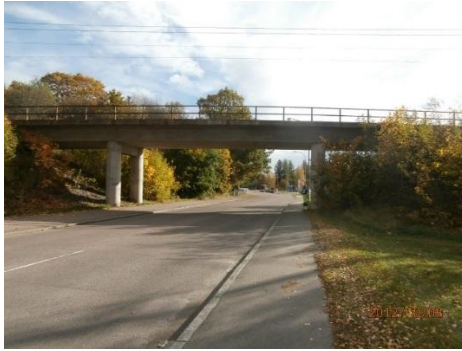
Figur 9 Bro 3500-3308-1 över kommunal gata Gonäsvägen (cirka km 2/800, väg 608 och järnväg). (Foto Trafikverkets databas BATMAN)
