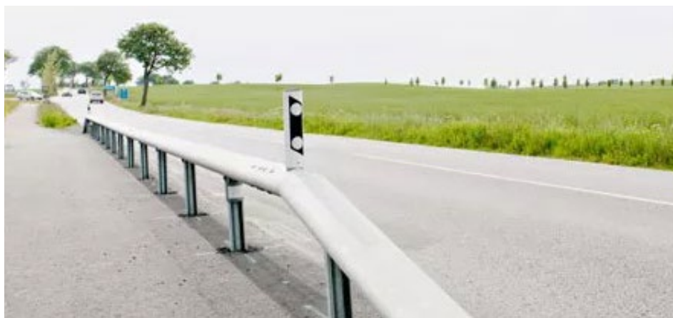
Figur 14. Stålbalksräcke med mjuk profil. Bild: Trafikverket, Gång- och cykelväg mellan Vekerum och Stilleryd.
