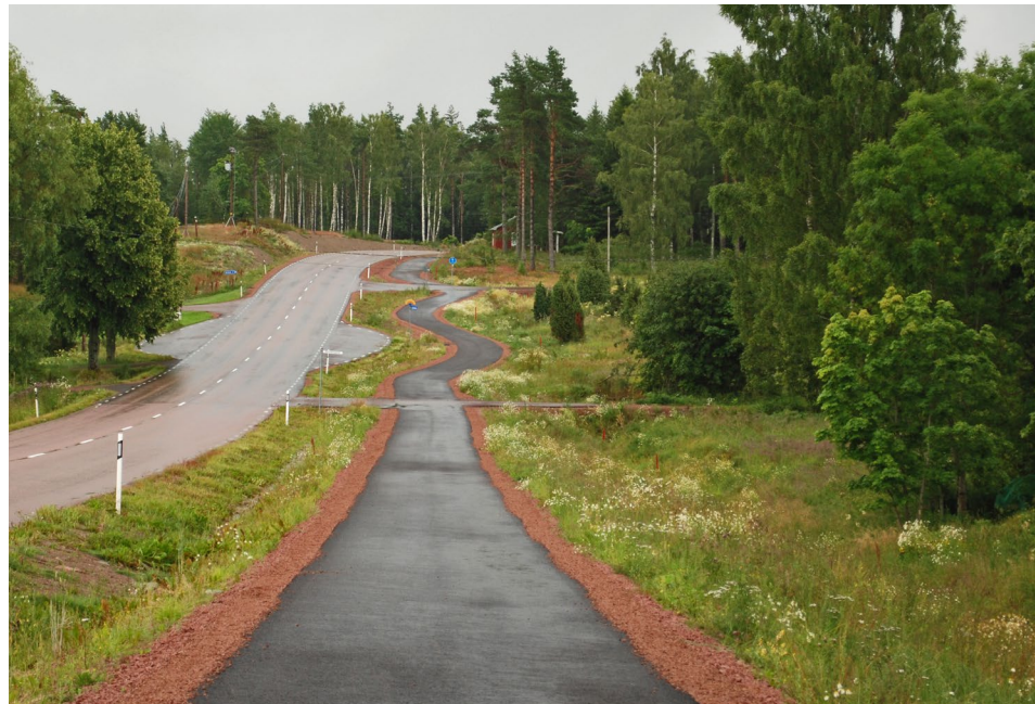
Figur 4. Gång och cykelväg projekterad med mjuka, ur ett körperspektiv godtagbara radier som i längsperspektivet upplevs som skarpa.
