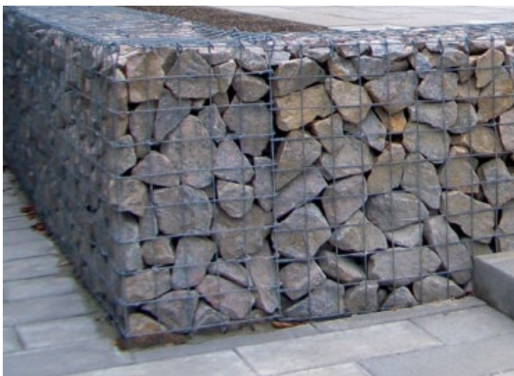
Figur 17. Gabionmur med stenar lagda med den breda sidan utåt.
