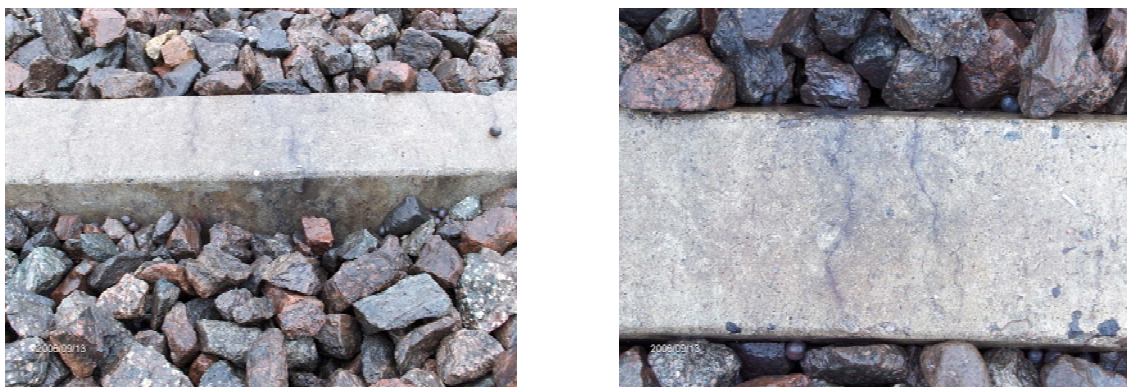
Figur 3 Typisk placering och utseende på sprickor i slipermitt vid Harrträsk
