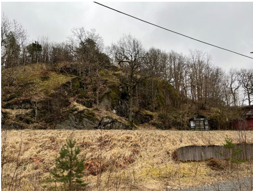
Figur 14 Vy från pendelparkeringen upp mot bergskärningen och stödmur i betong.
